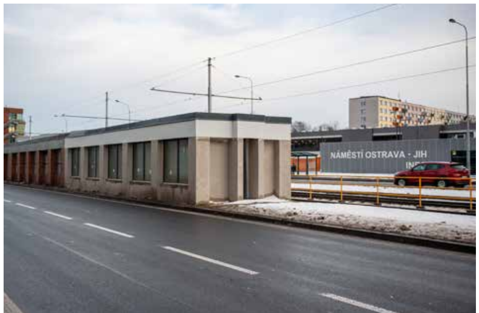
Rekonstrukce podchodu pod ulici Horní, náměstí Ostrava-Jih / 23 mil. Kč
